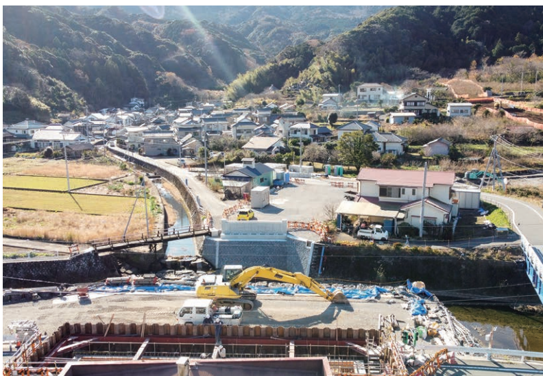
工事が進む町道山口雲見線(山口)
