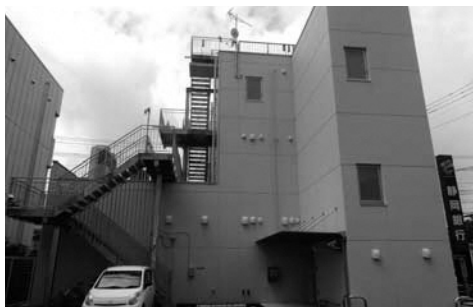
▲津波避難ビルとなった静岡銀行松崎支店
