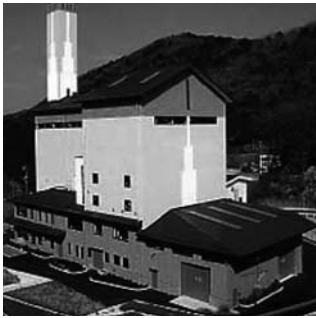
▶クリーンピア松崎 (供用開始後19年経過)
