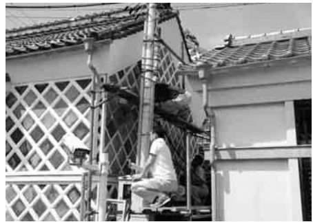
なまこ壁を施工している中瀬邸
