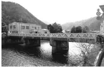
平成30年度に耐震補強補修工事を行う「常盤大橋」
