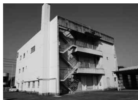
津波避難ビルとなったN T T松崎ビル
