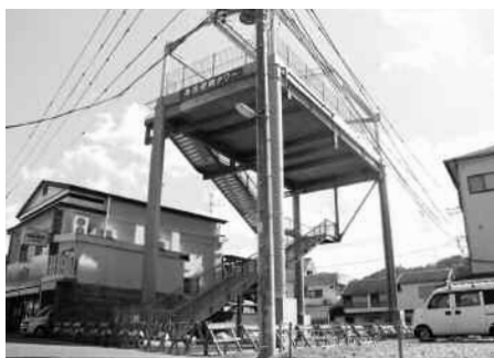
西区津波避難タワー
