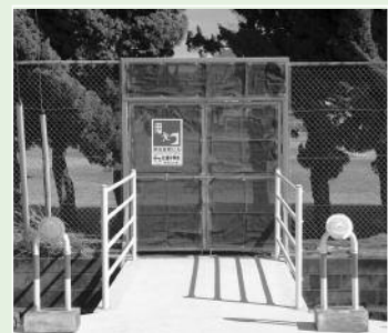
避難路としてフェンス扉と橋を整備
