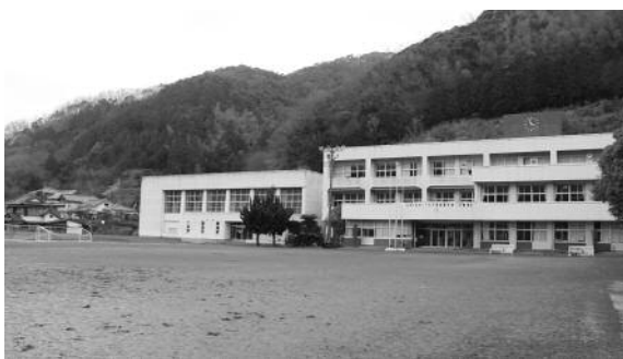
幼稚園の統合園舎の建設を予定している旧岩科小学校敷地
