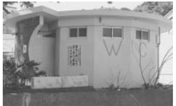
改修される雲見公衆トイレ
