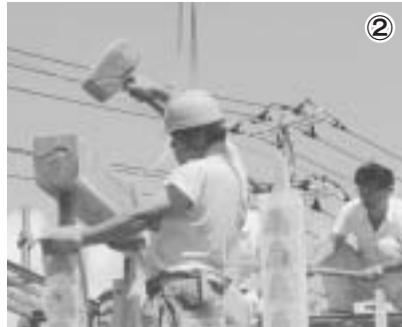
② 木工事（平成20年9月〜）
