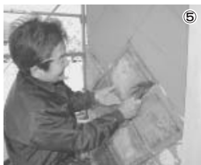
⑤ 瓦張り作業（平成21年3月〜）
