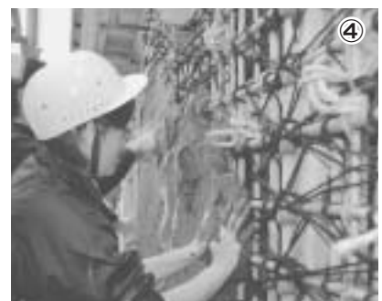
④ 荒壁塗り作業（平成20年11月〜）
