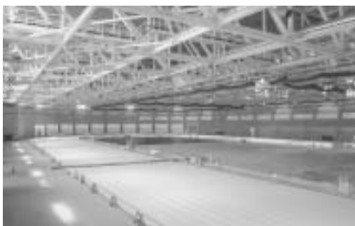
建設中の施設内部
