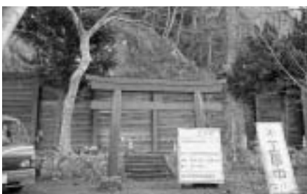
現在着工中の治山工事
