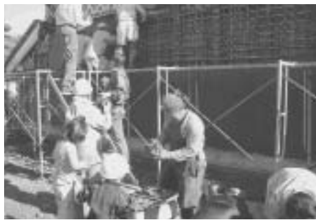
伊豆文邸での壁修復作業
