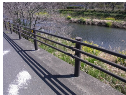
透過性の高いガードパイプ
