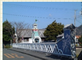
なまこ壁と漆喰画で装飾された橋の欄干と時計台は地域のシンボリックな存在となっている。 (ときわ大橋袂からの眺望)
