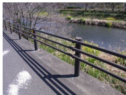
透過性の高いガードパイプ
