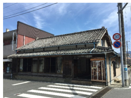
空き家であった旧石井豆腐店は、交流施設として活用されている
