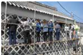
中瀬邸のなまこ壁の補修修理作業
