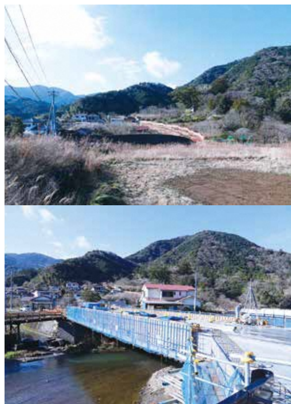
工事が進む町道山口雲見線(山口)
