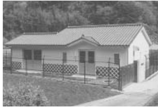
大沢取水ポンプ場
