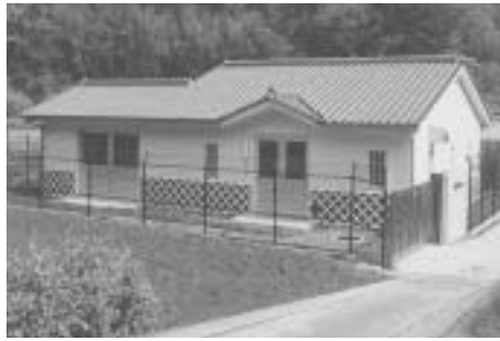
▲大沢新水源取水ポンプ場
