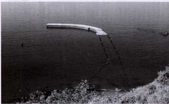
▲整備が進む松崎新港
