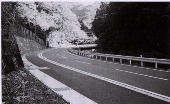
▲主要地方道下田松崎線（明伏地内）
