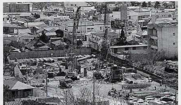
▲建設が進む松崎十字の園
