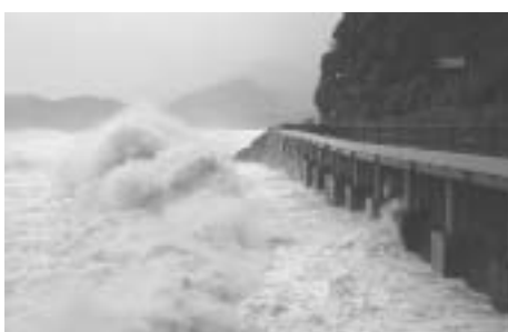
10月8日の高波の様子 (外部)
