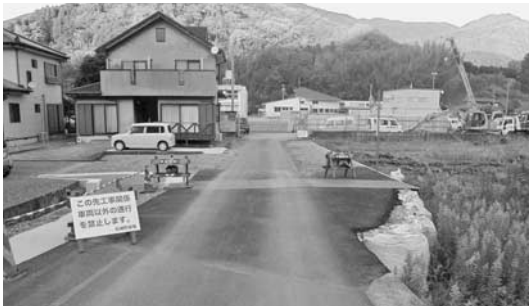
町道峰輪7号線拡幅現場
