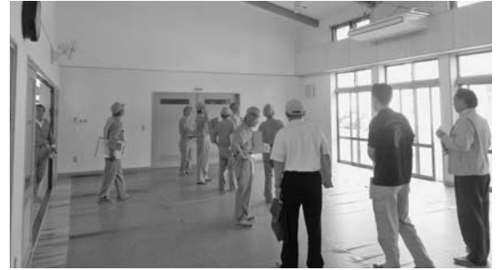
新築された松崎町立幼稚園（遊戯室）
