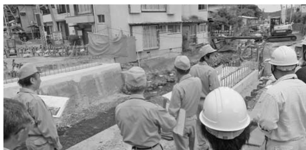
水道橋架替工事現場
