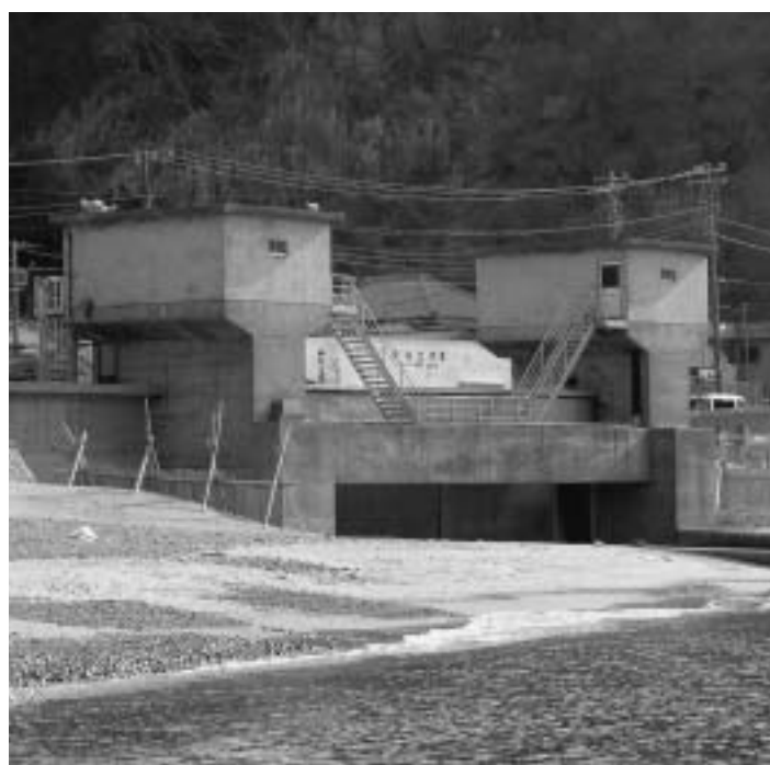
津波対策で設置された石部水門（津波想定6m）
