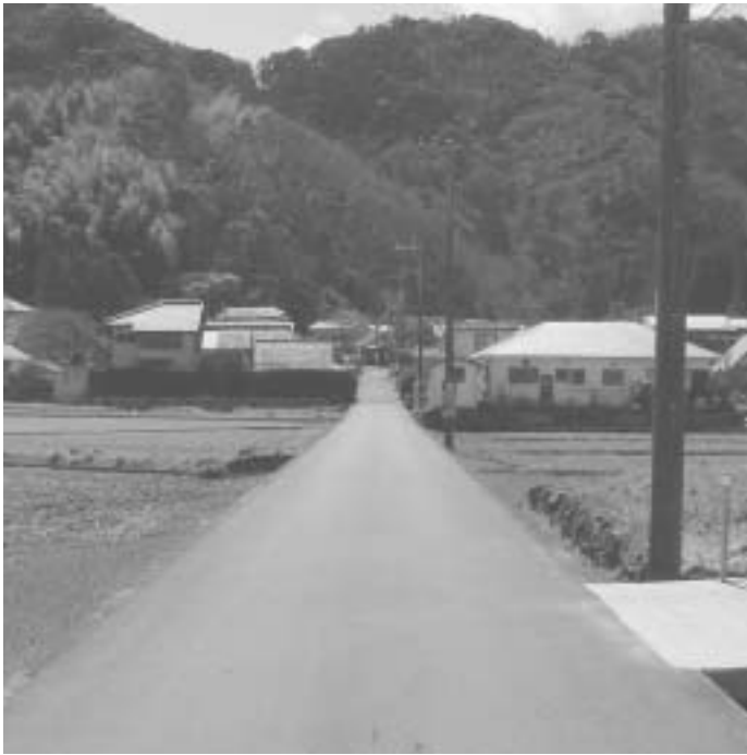
本管改良工事実施予定箇所（宮内）
