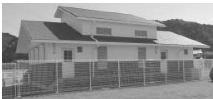
工事が完了した江奈ポンプ場
