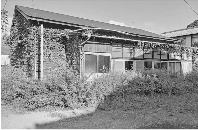
老朽化が著しい南区の旧武道館
