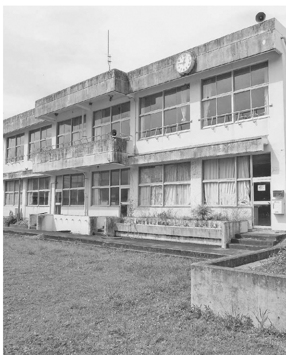
町有施設の解体修繕計画は
