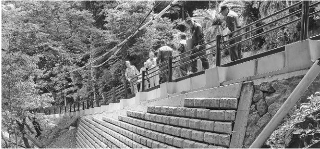
崩落した路肩が修復された町道石部線
