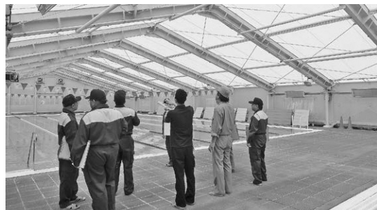
落下物除去と塗装補修が完了
