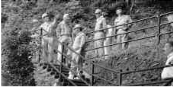
道部老釜(おいがま)地区津波避難路整備工事
