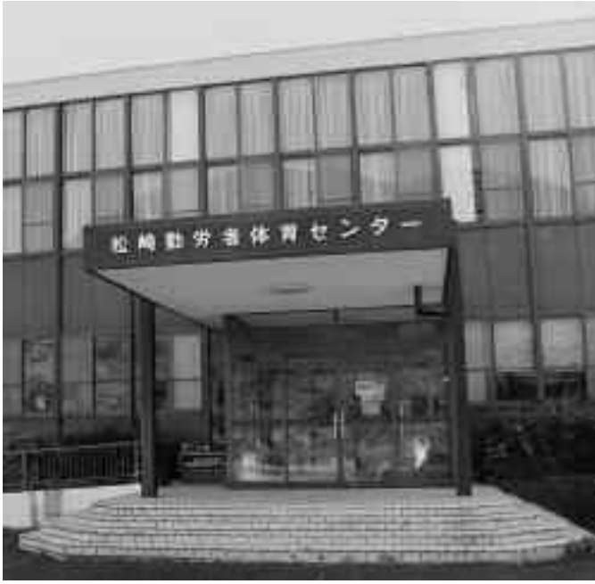
避難所となっている勤労者体育センター（道部）
