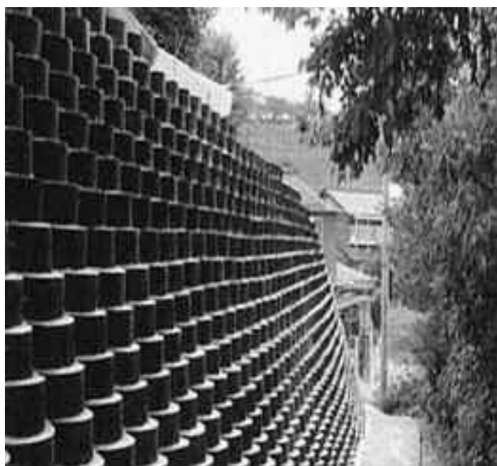
テラセル工法施工例
