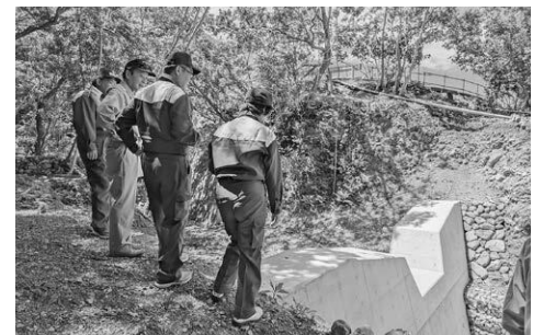
雲見風早地区の治山工事
