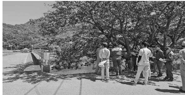
伏倉橋の橋梁補修
