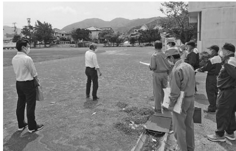
フィルタ材が敷設された松小グラウンド
