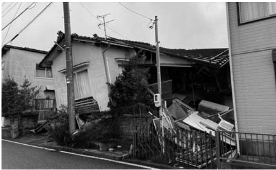
▲能登半島地震の被害の様子（県からの提供写真）
