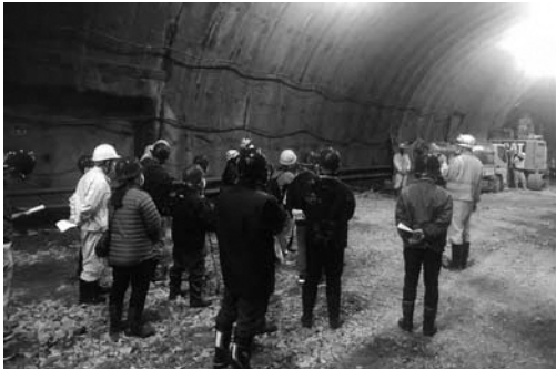
▲狸平トンネル(仮称)坑内掘削工事の見学会
