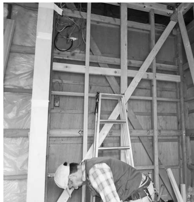
耐震補強工事の様子
