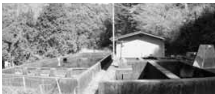
八木山浄水場
