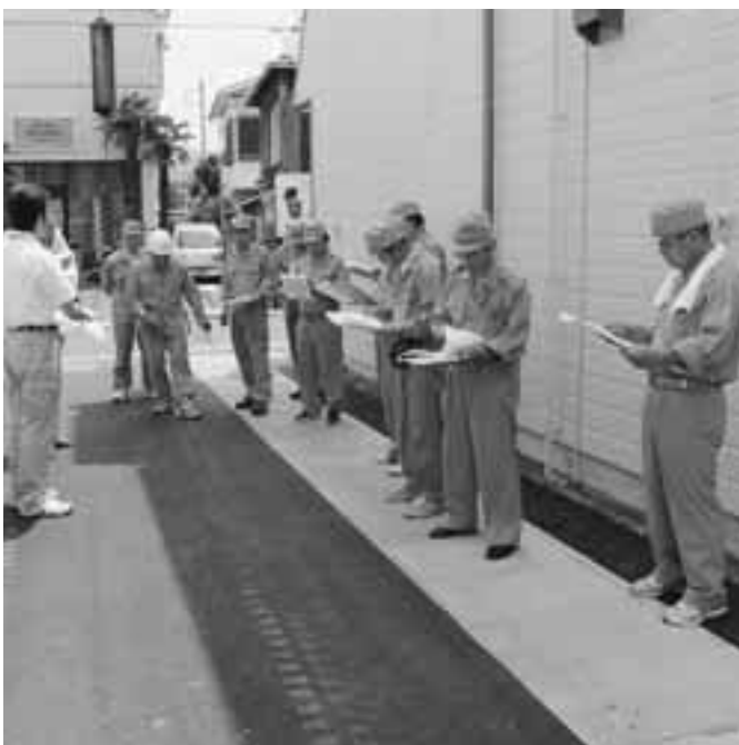
松崎地区浸水対策工事箇所
