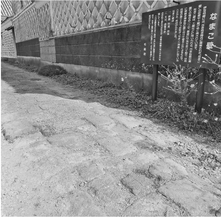
なまこ壁通りの劣化した石畳
