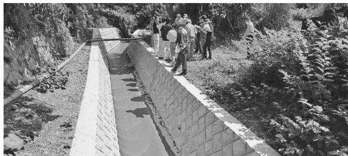
河川改修工事 (完成区間)
