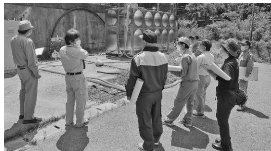
設置された急速ろ過装置など
