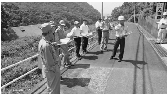
舗装補修と水道本管改良（町道石部線）
