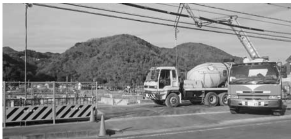
建設が進む西伊豆消防署新庁舎 （西伊豆町中地区）
