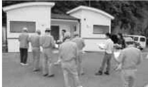
石部地区に整備された多目的公衆トイレ
