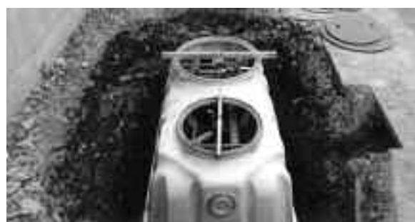
設置中の合併処理浄化槽
