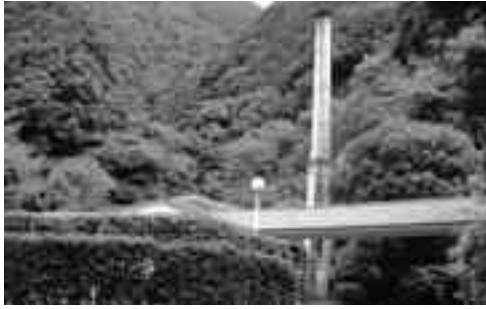
煙突の補強工事を行った斎場（西伊豆町）
