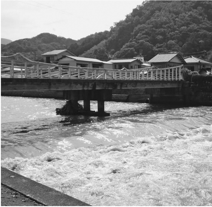
今後の台風への対応は（増水後の那賀川河口）
