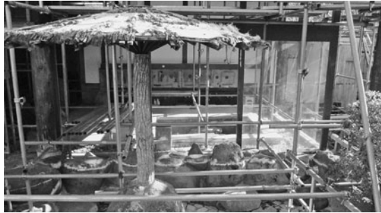
工事が始まった旧依田邸
