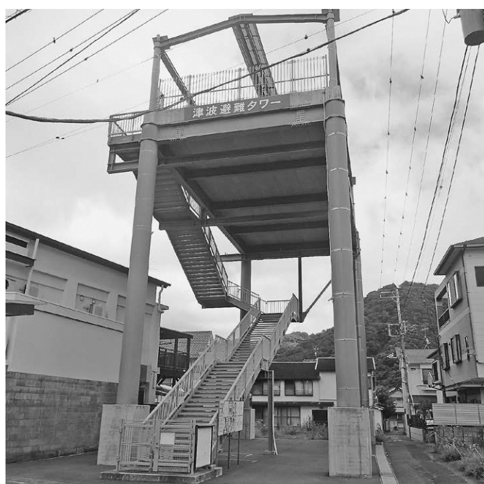
津波避難タワー
