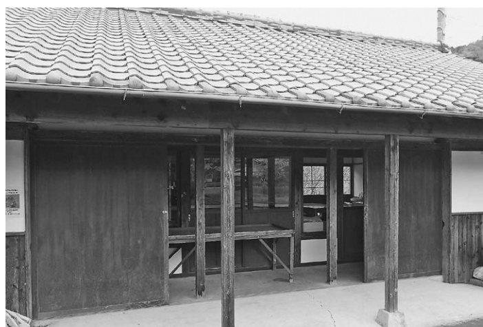
近年使用されていない三聖苑作業棟
