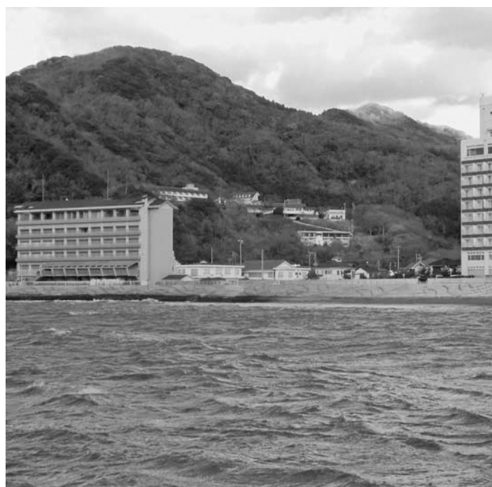
対策が検討される防潮堤 (松崎海岸)
