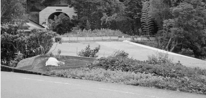
伊豆縦貫道アクセス道路（下船原トンネル付近）
