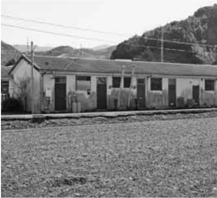
町営細田住宅の建替えは (伏倉・町営細田住宅)
