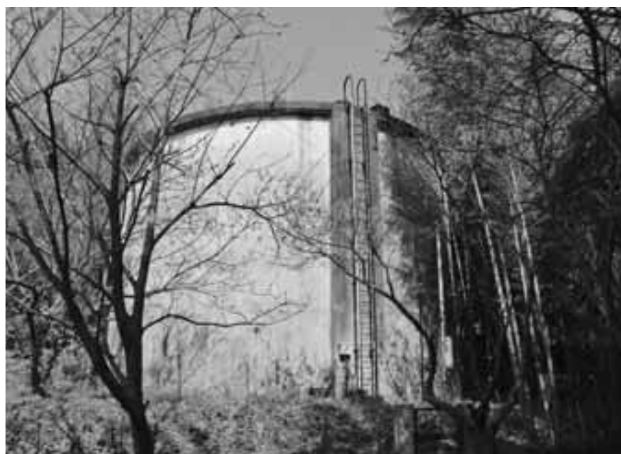
水道施設の老朽化対策は (伏倉配水池)
