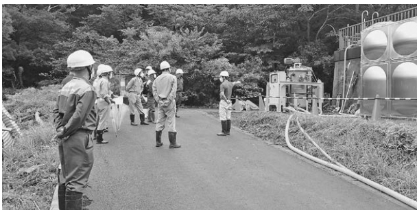
雲見に設置されたろ過装置
