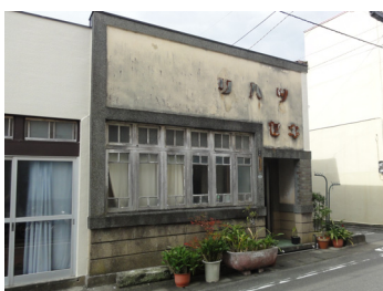
モルタル塗りの外壁と洋風の窓が、昭和レトロの雰囲気を醸し出している。
