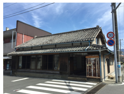
空き家である旧石井豆腐店は、協働作業場として再生活用がされる
