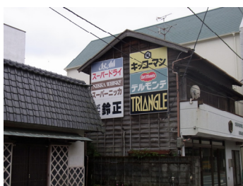
昔ながらの看板は、シンプルなデザインで古い木造建築物に馴染んでいる。
