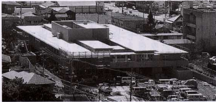
▲建設が進む松崎十字の園
