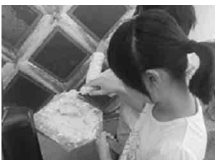
▲「なまこ壁」修繕体験の様子
